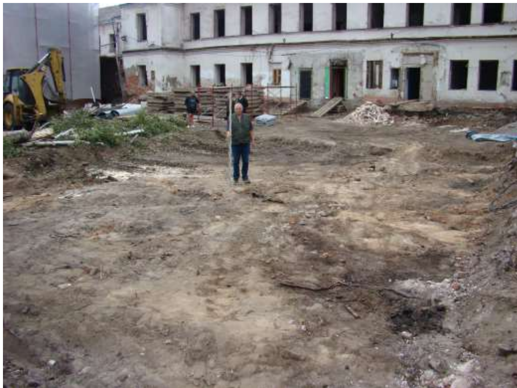
Рис. 10. Археологические раскопки во дворе д.5 по пер. Советскому в г. Ярославле. Площадка до начала работ. Вид с востока.
